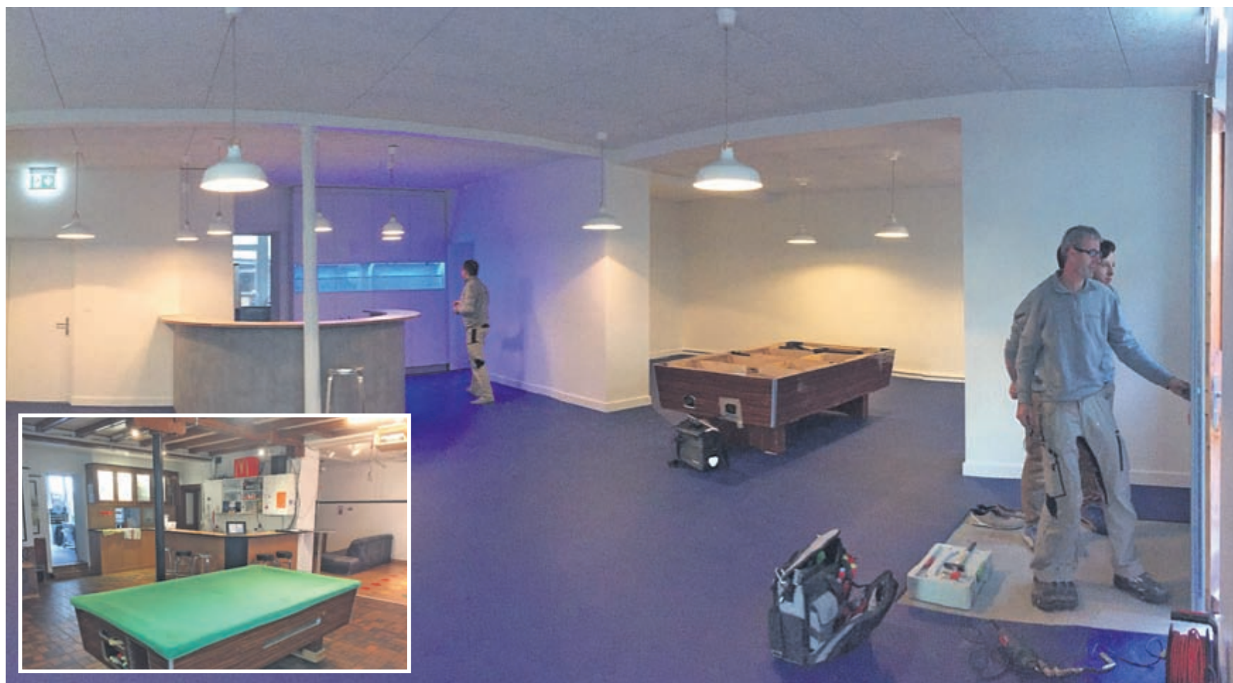
Kaum wiederzuerkennen: die Innenräume des «Go-In» vor und nach der Renovation.
